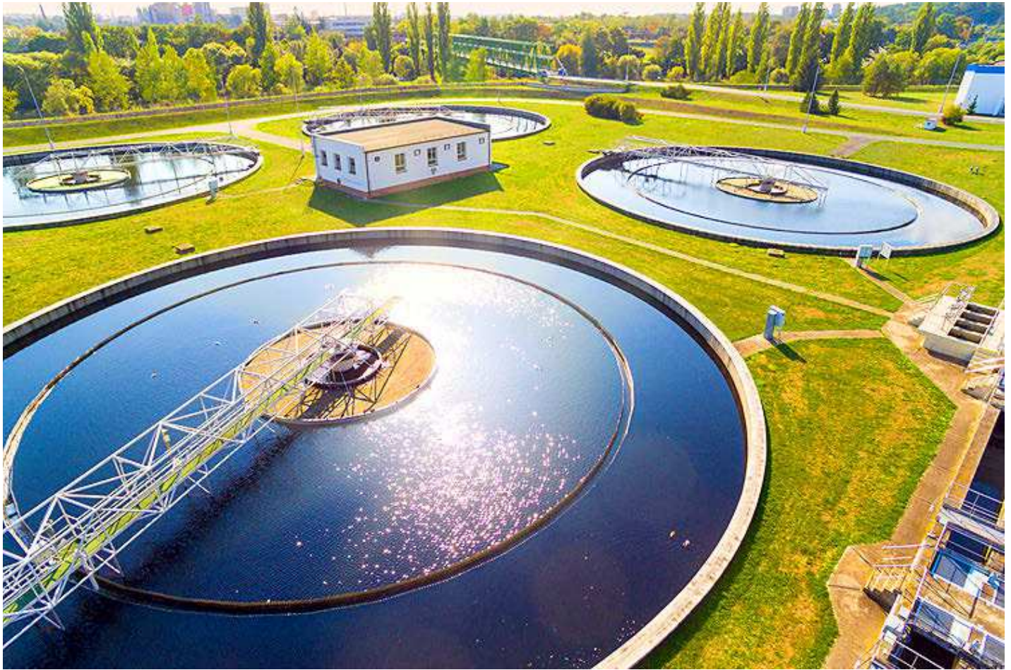
Imagen de una depuradora.
